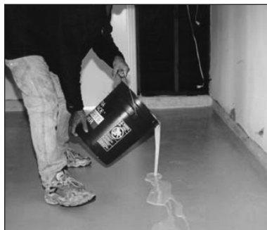
Pour epoxy next to starting edge
