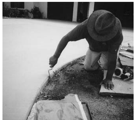
Raspe o cepille las orillas verticales donde el material gotea hacia los lados.
