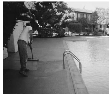
6. Aplique Concrete Colorcoat usando rodillo.
