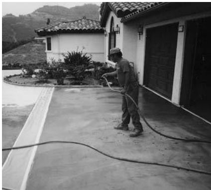
1. Asegúrese de encintar las áreas circundantes y humedezca la superficie con agua donde desea comenzar a esparcir el material.
