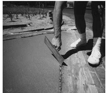
4. Raspe cualquier material que entre en las juntas usando una paleta o raspador antes que seque demasiado
