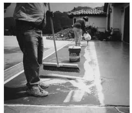
3. Antes que la primera hilera de material se acabe, vierta otra hilera encima de la primera y si es necesario, rocíe más agua donde se necesite.
