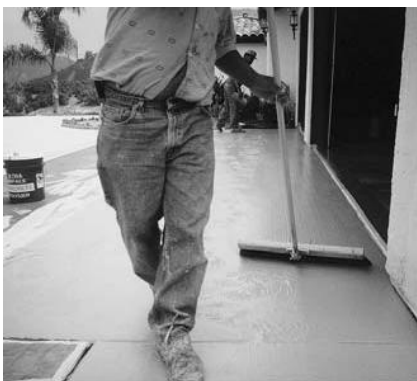
2. Esparza el material Fine Broom Finish en una capa uniforme y delgada junto a la orilla inicial utilizando un jalador metálico y escoba para dar el acabado deseado.
