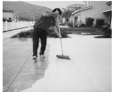
Aplique una capa de Squeegee/Bond Coat usando jalador metálico de 24"
