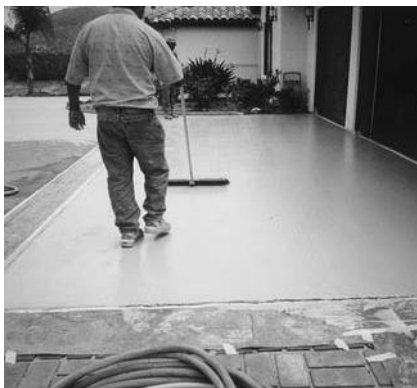
Cepille inmediatamente detrás del jalador metálico para dejar la textura deseada.
