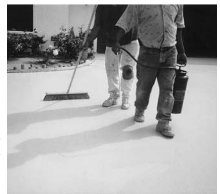
7. Aplique Sealcoat 1000 usando atomizador y escoba de cerdas suaves.
