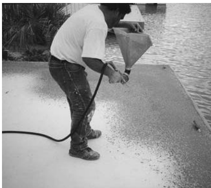
Rocíe la mezcla de Ultra Surface Trowel Knockdown usando un atomizador de tolva.
