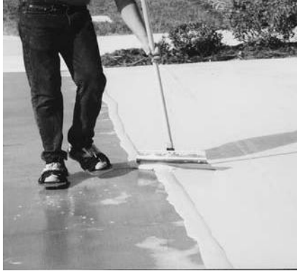
Aplique Squeegee/Bond Coat de Ultra Surface Polymer Concrete sobre la superficie.
