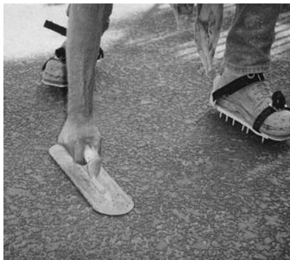
Aplane la mezcla de Trowel Knockdown Texture para conseguir la textura deseada.
