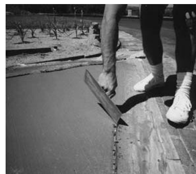
Raspe cualquier material que penetre en las juntas usando llana o raspador antes de que seque.
