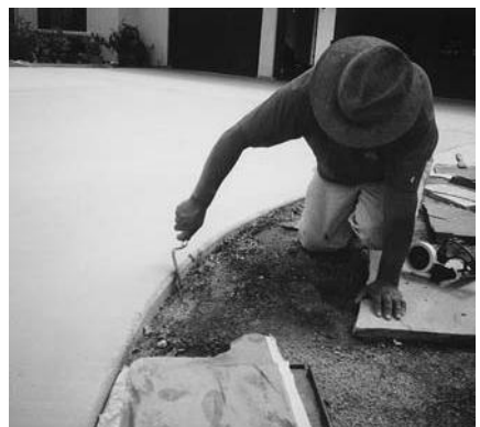
Raspe o cepille las orillas verticales donde el material gotea a los lados.
