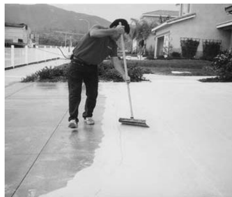
Aplique Squeegee/Bond usando jalador metálico de 24".
