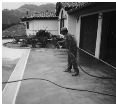
Humedezca la superficie con agua donde desea comenzar a aplicar Squeegee Coat Mix .
