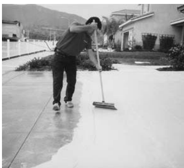
Esparza la mezcla de lado a lado, en líneas rectas usando un jalador de orilla metálica.
