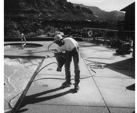
Rocíe *Spray Texture Mix* sobre la superficie usando pistola atomizadora de tolva.
