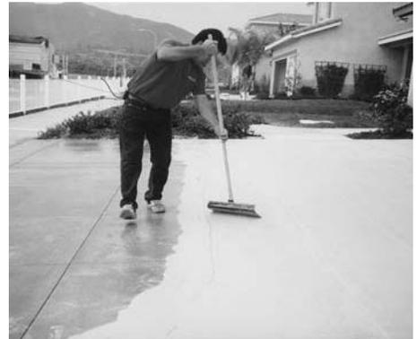
Aplique una capa Squeegee/Bond Coat usando jalador metálico de 24".
