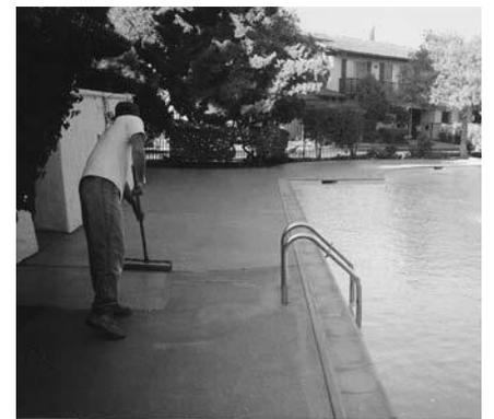
5. Después de soplar la superficie, aplique dos capas de *Concrete Colorcoat* con rodillo de pintar.
