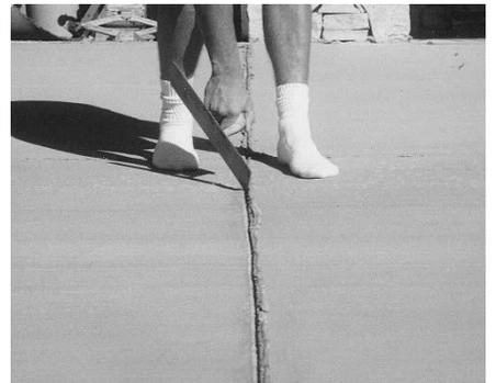
4. Raspe cualquier material que quede entre las juntas usando una llana o raspador antes que seque muy duro.
