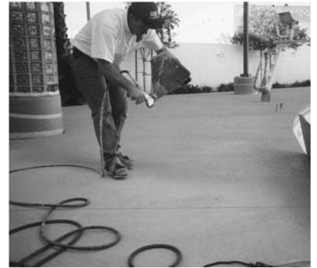
15. Aplique el acabado deseado
