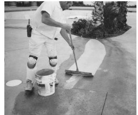
9. Vierta la mezcla de parche sobre la fisura
