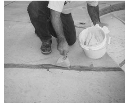
3. Rellenando con mezcla de arena y Epoxy 500
