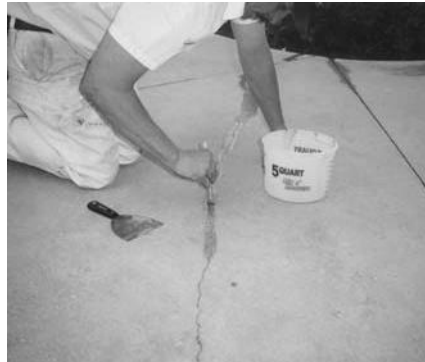
2. Imprimando con Epoxy 500.
