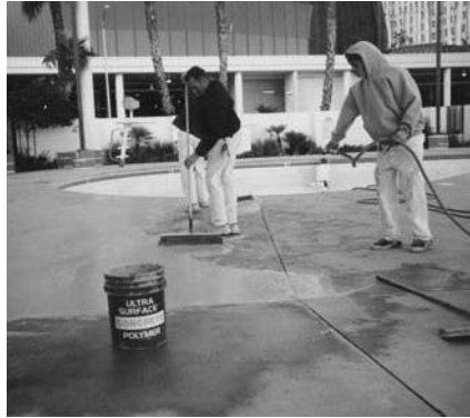
14. Aplique Squeegee/Bond Coat sobre toda la superficie
