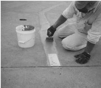
7. Aplique Elastomeric Basecoat sobre la tela.
