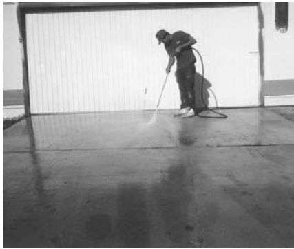
1. Lavando a presión las fisuras.
