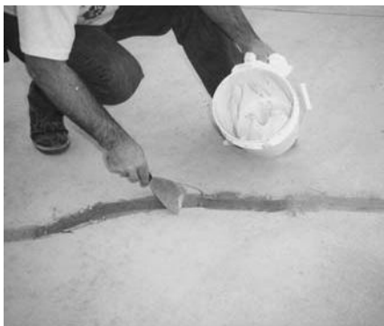
4. Raspe el exceso de mezcla con arena.
