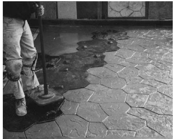
Acabado de concreto Estampado 1/4"
