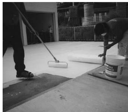
Coloque la siguiente hilera de tela para que se traslape a la orilla de la hilera anterior 2½-3 pulgadas. Continúe colocando hileras de tela hasta que toda la superficie este cubierta.
