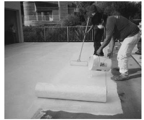
Aplique Elastomeric Basecoat encima de la tela a 100 pies 2 (9.26 metros 2 ) por galón después de desenrollar varios pies esparcir ligeramente arena sílice #60.
