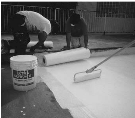
Cuando llegue al final de la cubierta, corte la tela con navaja o tijeras y comience a colocar la siguiente.
