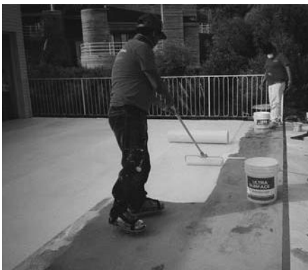
Aplique Elastomeric Basecoat por delante de la tela a una proporción de 100 pies 2 (9.26 metros 2 ) por galón.
