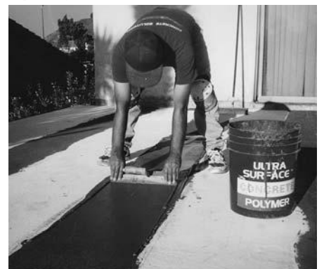
Si aplica un sistema delgado de recubrimiento sobre la tela, será necesario primero parchar las costuras con Ultra Surface Polymer Concrete usando paleta o jalador metálico y aplicar Squeegee/Bond Coat sobre toda la superficie.
