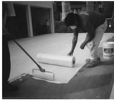
Desenrolle la tela dentro de la capa base elastomérica húmeda pocos pies a la vez.
