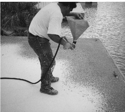
Roció la mezcla de Textura Ultra Surface usando una pistola atomizadora de tolva
