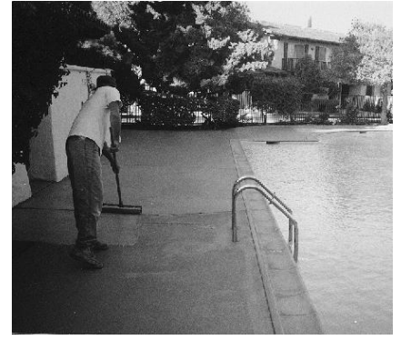
Aplique Concrete Colorcoat sin diluir usando un atomizador sin aire o rodillo para pintar de 3/8 - 1/2". Aplique una capa superior de Sealcoat 1000 transparente en andadores.
