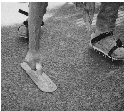
Aplane la Mezcla Spray Texture Mix para conseguir la textura deseada.
