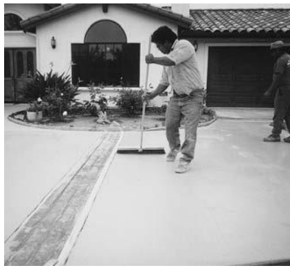
Aplique Fine Broom Finish o Swirl Pattern Finish sobre la capa de adhesión ya seca.
